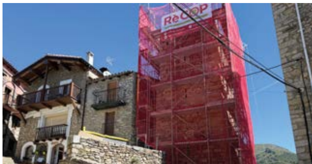
Obres de rehabilitació de la Torre de la Presó / Feliu Sirvent
