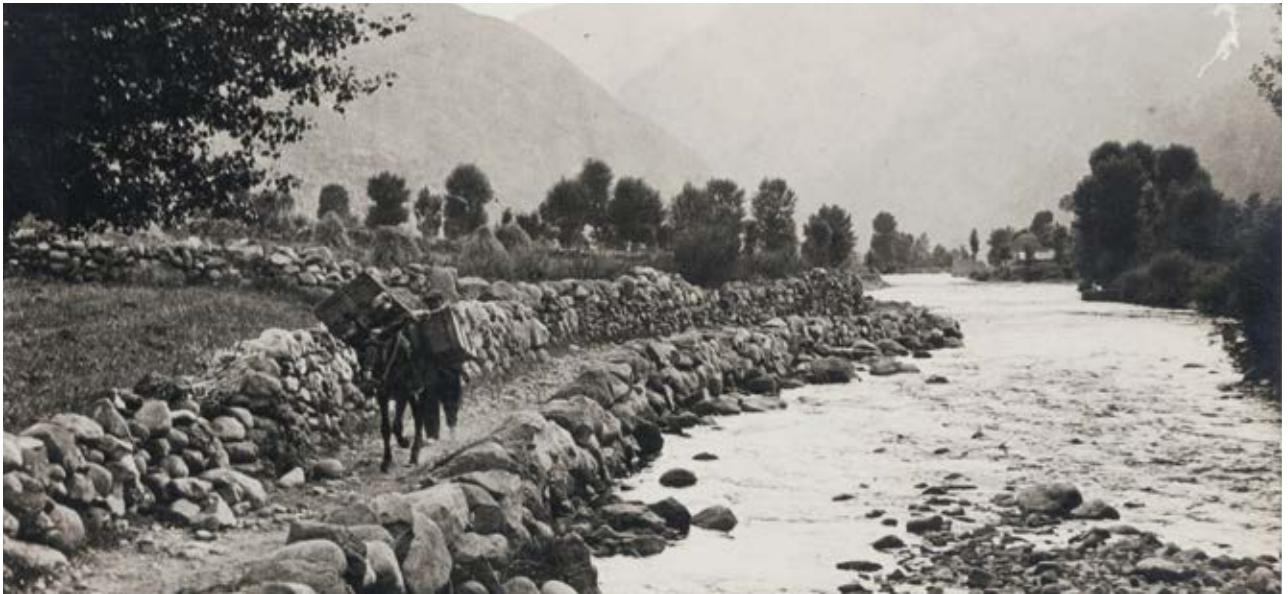
El camí de ferradura al Santuari i Balneari de Caldes de Boí, ara fa un segle, discorrent al costat mateix de la Noguera de Tor. Els murs de pedra seca guardaven el traçat d'aquesta important via de comunicació. En primer terme, un discret transeünt condueix un animal de bast carregat de vitualles cap al poble de Barruera. Al fons, la plana d'Erill amb un camp acabat de segar, els arbres de ribera i els estreps de Besiberri i la vall de Sant Nicolau. Targeta postal fotogràfica estàndard. Autor desconegut. Axiu familiar de cal Serni de Cabó, TC_821 (2)/2026.
