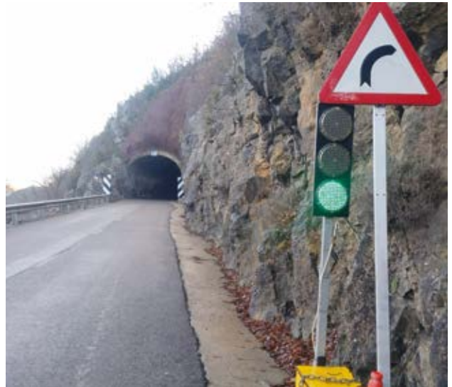
Tram N-260, túnel de Viu entre Xerallo i el Pont de Suert / CCAR
