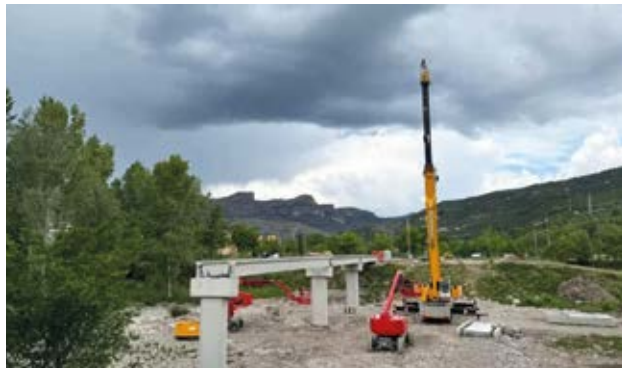
Obres de la nova passarel·la / Ajuntament de La Pobla de Segur
