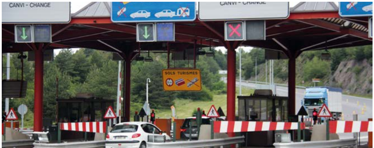
Peatge del Túnel del Cadí, a la carretera C-16, al tram de la Cerdanya / ACN
