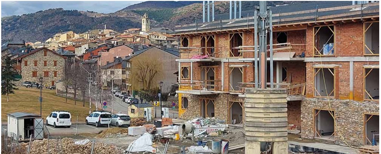
Una promoció urbanística en construcció a Bellver de Cerdanya / Feliu Sirvent.
